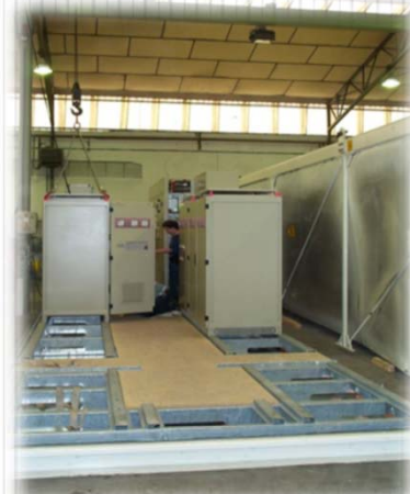
Instalación de equipos sobre estructura base
